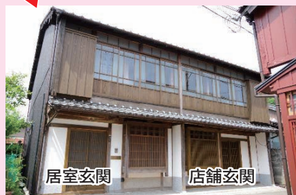
アフター① 外観正面
