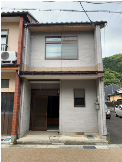
↑玄関先は鹿島の通りに面しています。
