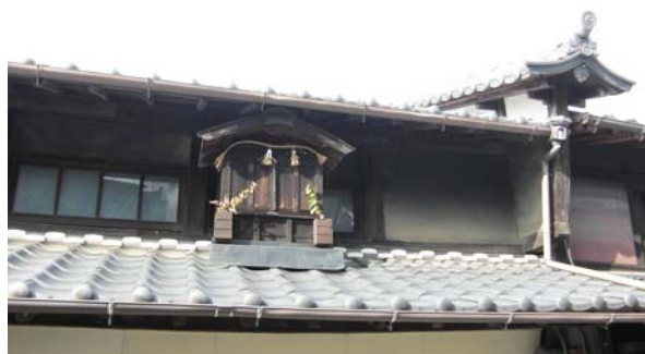
下屋庇上に設けられた辻堂風
