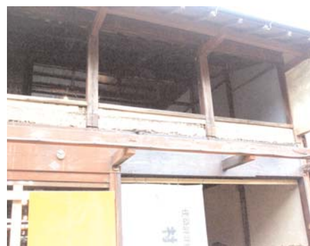
改修工事の様子
