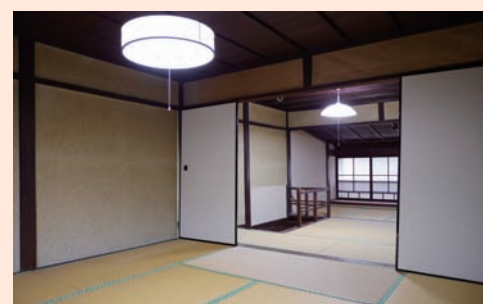
(改修前) 2階 奥の間
