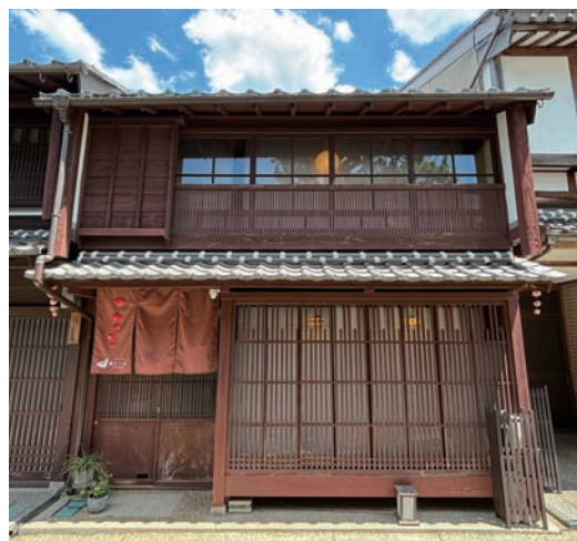
改修後の外観
