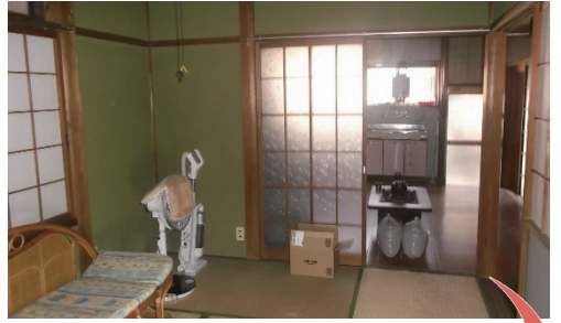
改装前 付属建物 和室からキッチン
