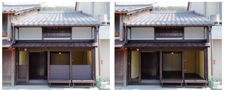
摺り上げ戸を開けたところ (右は全開したところ)
