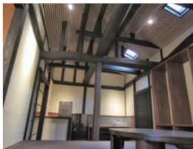
▲改修後 (2階居間)
