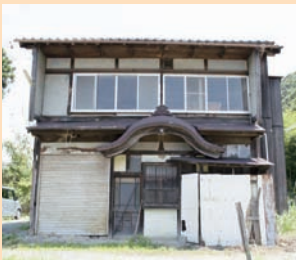
改修前の大師湯前景
