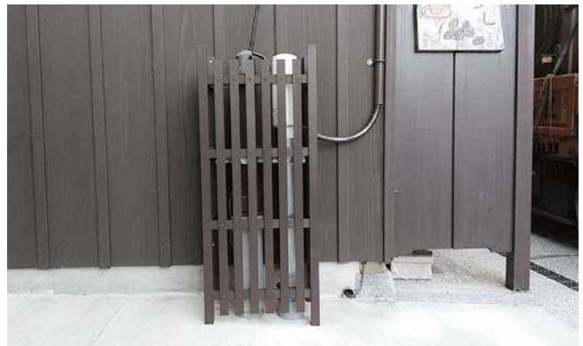
各家の配線工事
