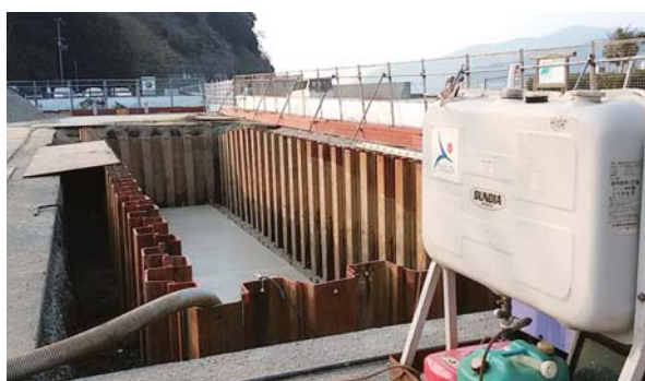
消雪装置工事の様子
