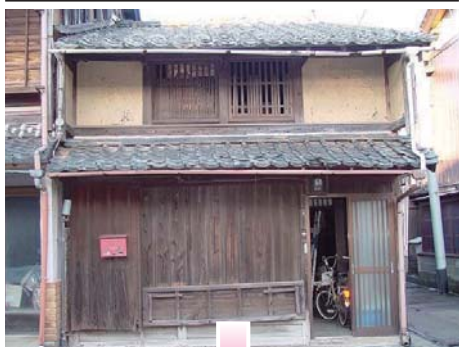
横山家主屋（小浜住吉）修理
