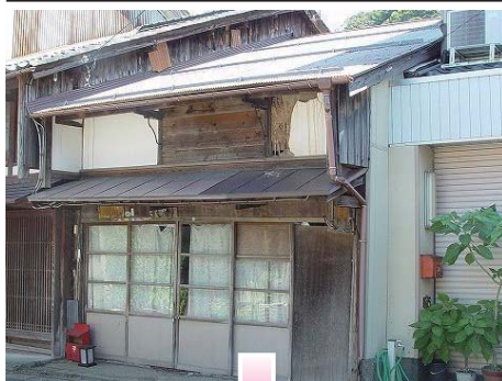
岡田家主屋（小浜鹿島）修理
